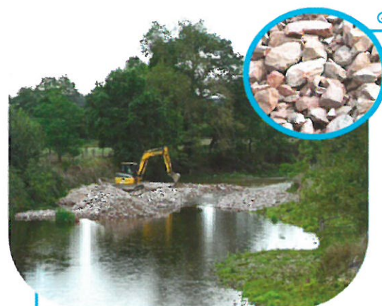
Travaux de recharge en granulat sur l'Argenton
